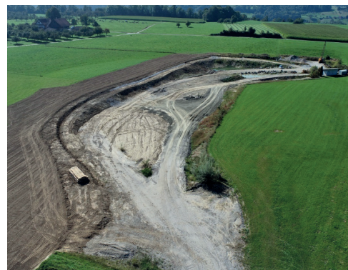
Rekultivierungsarbeiten Hohentannen Nord 2019
