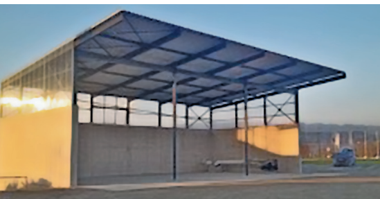
Neue Halle zur korrekten Lagerung von belasteten Materialien in Bürglen
