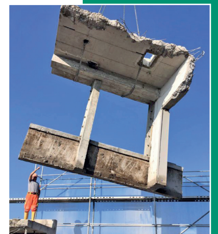
Bis zu 6 Tonnen schweres Betonelement
